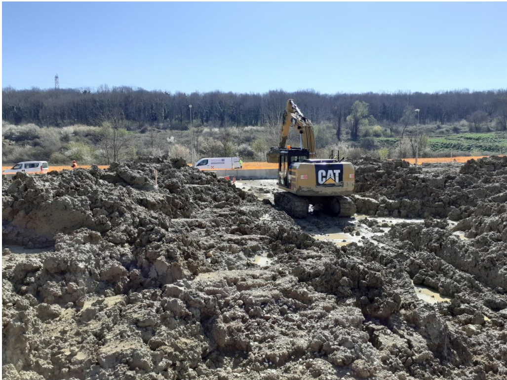
Figura 4 - escavatore durante le fasi di campionamento sulla pista allo scopo realizzata in piazzola
