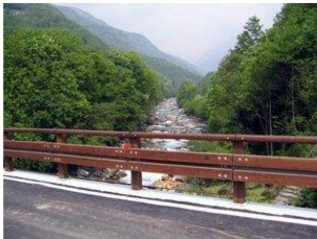
**Figura 5-9: Barriera tipo H2 Bordo Ponte in Cor-Ten**
