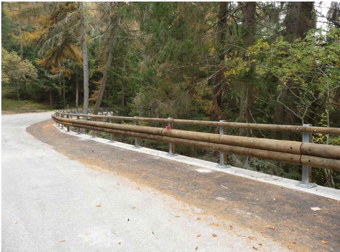
**Figura 5-16: Barriere tipo H2 BP in legno con anima in acciaio**
