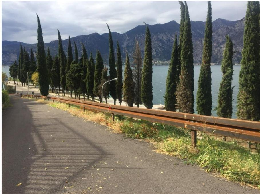
**Figura 5-8: Barriera tipo N2 Bordo Laterale in Cor-Ten**
