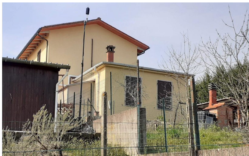
Figura 11: Installazione fonometro per le misure acustiche - R01-R2
